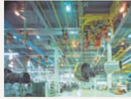
搬运喷气式飞机引擎起重机系统
